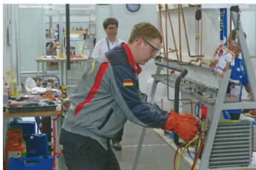
Julian Walz beim Einfüllen des Kältemittels
